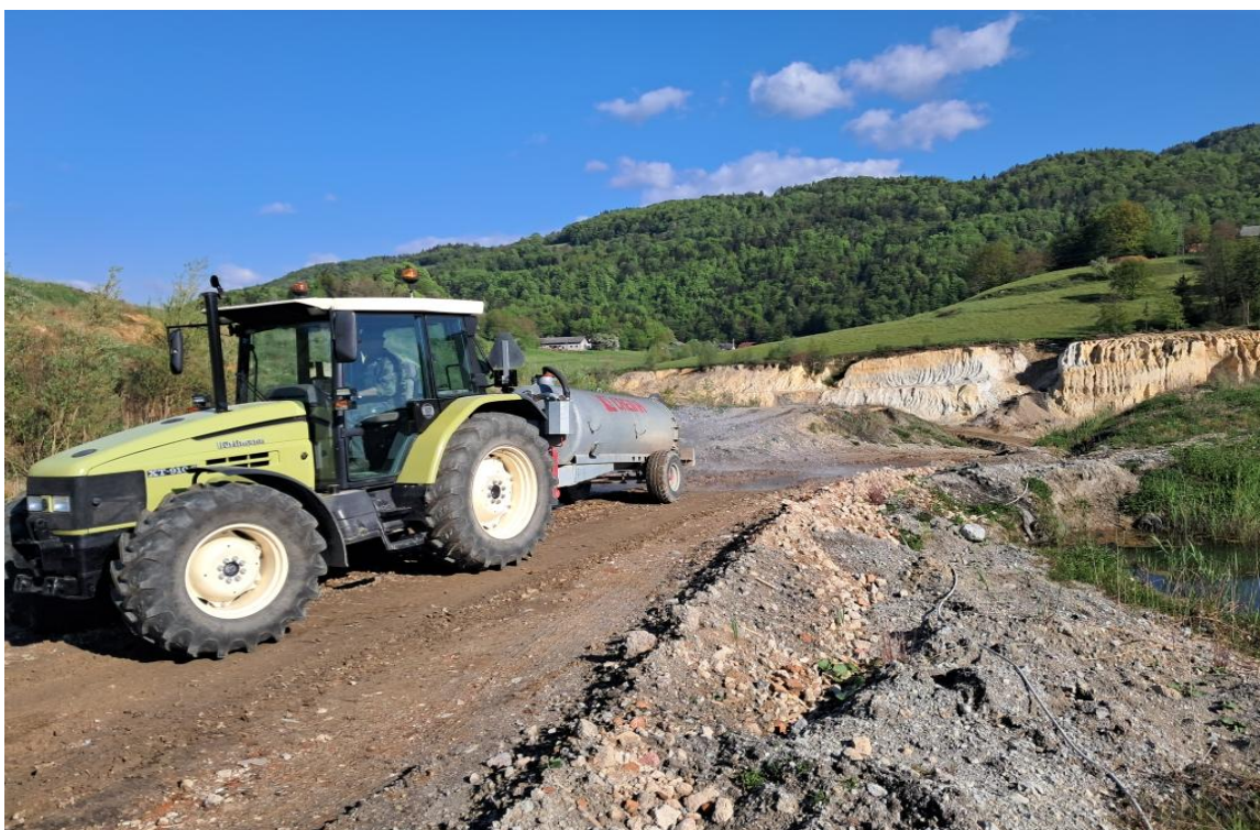
Slika 24: Močenje transportnih cest na območju peskokopa v makadamski izvedbi
